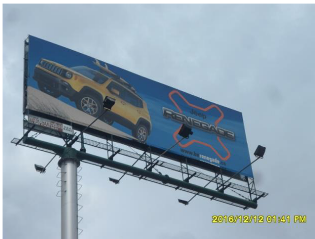
SENTIDO SUR-NORTE DE LA VALLA TUBULAR
